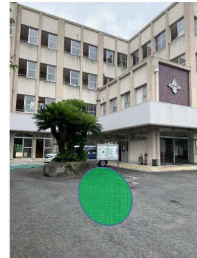
⑦小学校前 小学校玄関ホール横ソテツ前
